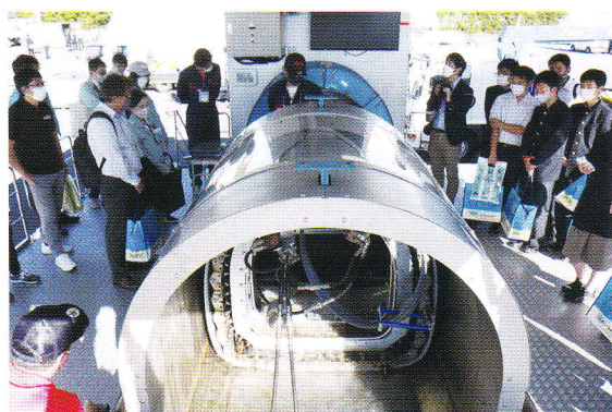
SPR ブラック号による製管デモ施工
